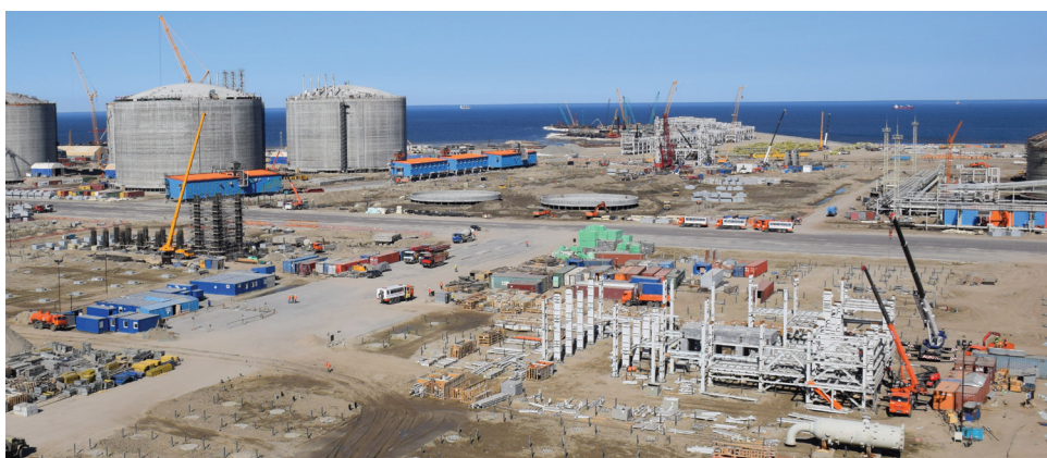
Выполнение строительно-монтажных работ п. Саббета «Ямал СПГ»
